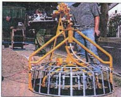
**Fig. 7 - Bobina de armazenamento passivo, acionado pelo equipamento de sopramento, para aumentar o comprimento de cabo**
