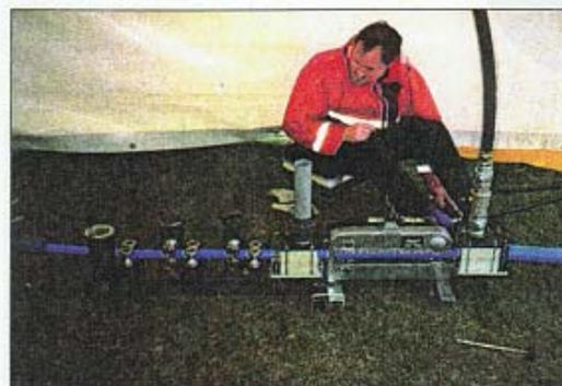
Fig. 3 - 3,8 toneladas (recorde mundial) de sopramento de ar de cabo (150 x 4) com 35 mm de diâmetro por 2 km de duto de 63/51 mm, usando-se dois compressores em cascata
